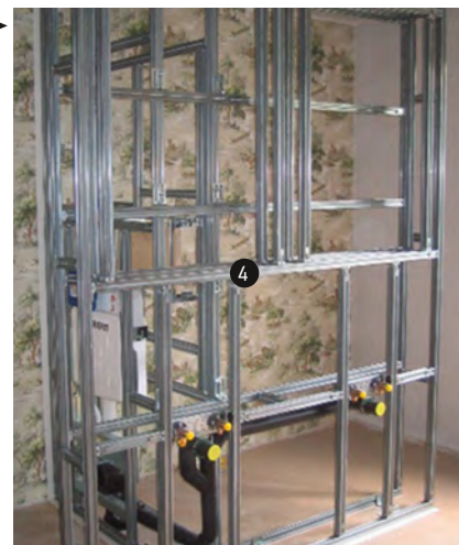
[FIG. 3] 4 Sistema d'installazione sanitaria
