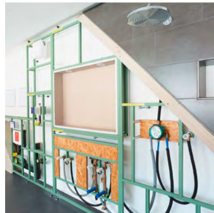
[FIG. 10] Sistema sanitario prefabbricato con tubazioni preinstallate.
